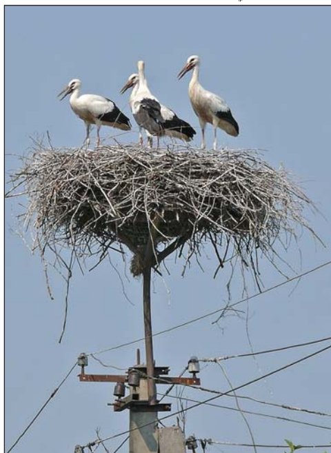
Фото 4. Платформа, поднимающая гнездо на столбе над проводами.
